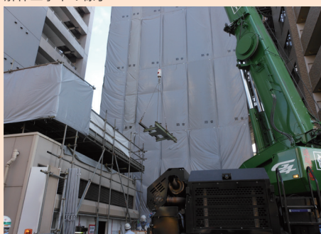
解体工事の様子
